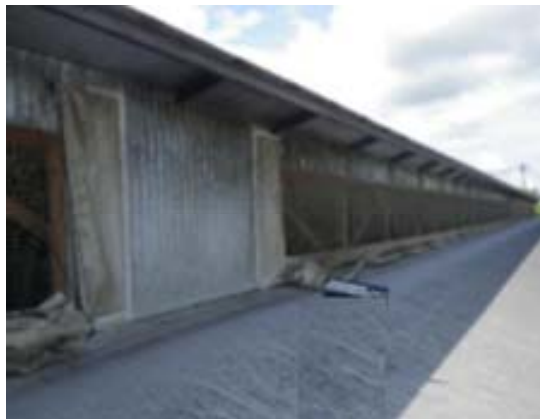
脱臭装置の設置前
