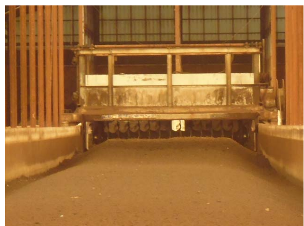
写真5 攪拌機（二次発酵槽）
