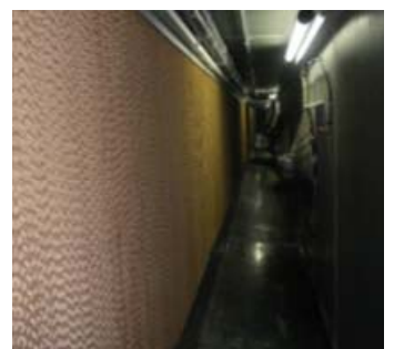
ハニカム状のフィルター 肥育舎内→フィルター① フィルター①→フィルター② フィルター②→排気ファン
