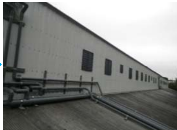
脱臭装置の設置後
