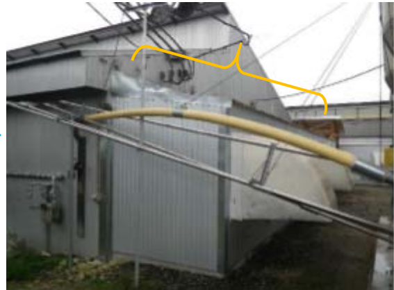
脱臭装置の設置後
