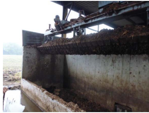
写真6 原料槽からクレーンで投入
