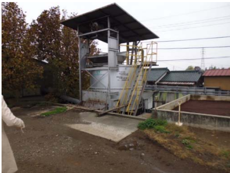
写真8 密閉縦型発酵装置
