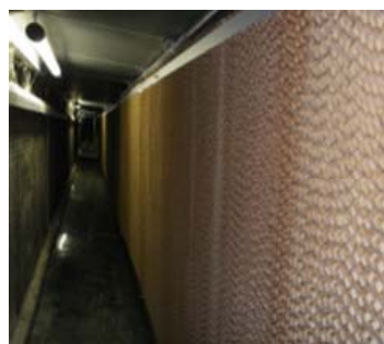
ハニカム状のフィルター 肥育舎内→フィルター① フィルター①→フィルター② フィルター②→排気ファン
