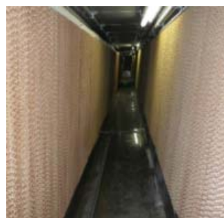
ハニカム状のフィルター 肥育舎内→フィルター① フィルター①→フィルター② フィルター②→排気ファン
