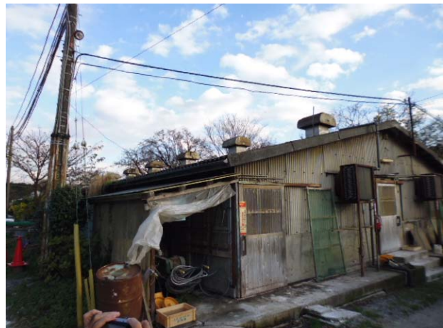
写真2 豚舎の屋根上の換気扇は停止中
