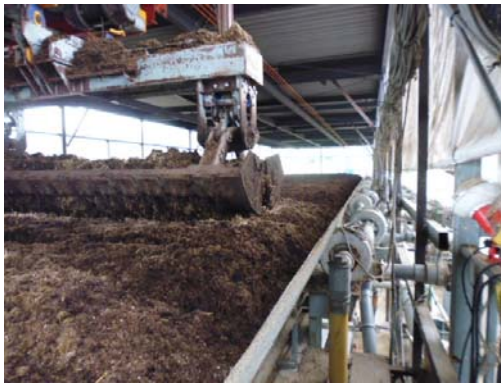
写真7 発酵槽の上部
