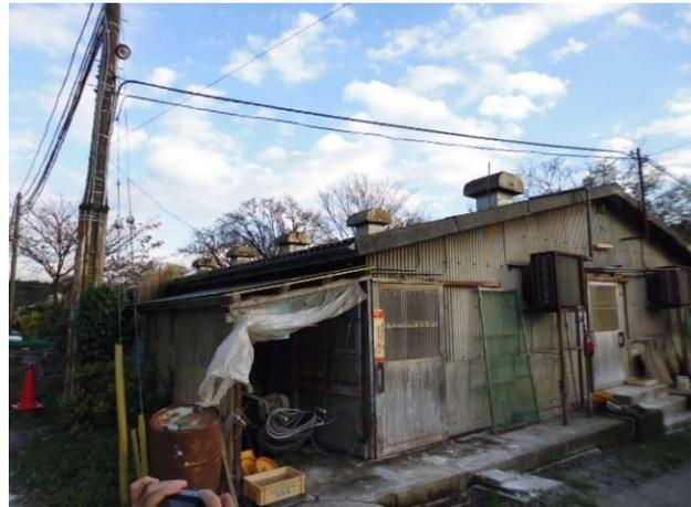
写真2 豚舎の屋根上の換気扇は停止中
