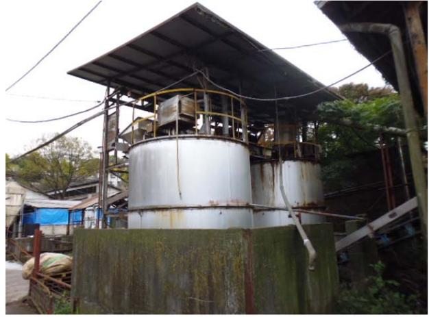
写真8 密閉縦型発酵装置 (C社2基)
