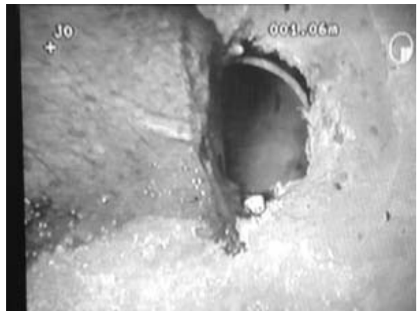
写真2 テレビカメラにより発見された不明管
