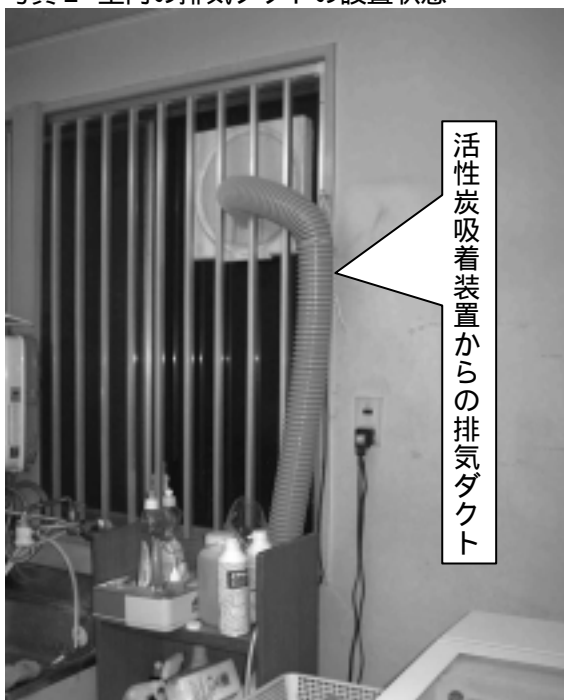
写真2 室内の排気ダクトの設置状態
