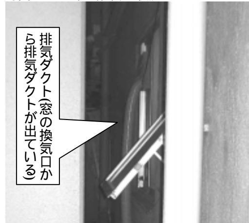
写真4 ダクト末端の臭気放出部分
