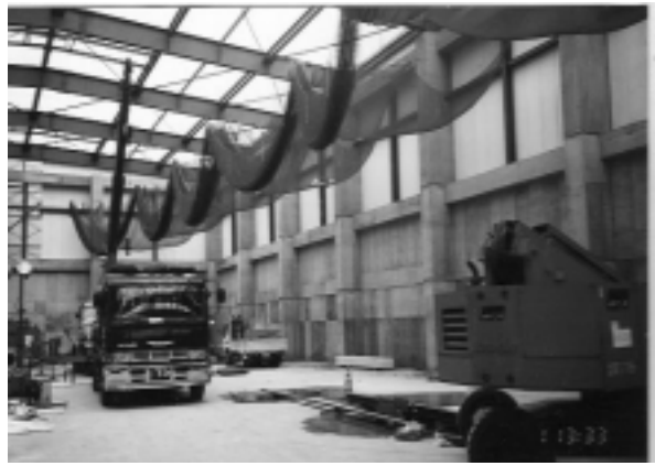
写真2 工場建設途中の状況（その2）
