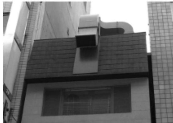
写真3 改善後の排気口の吹き出し部分
