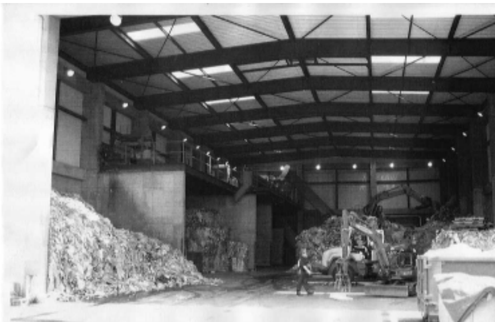
写真3 工場完成後の状況
