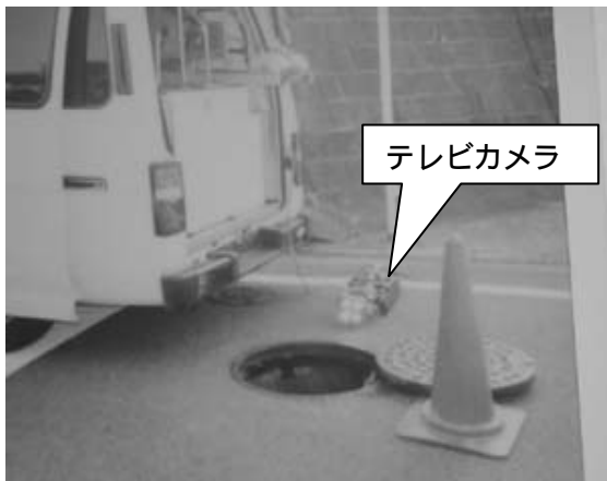
写真1 テレビカメラによる下水管の調査
