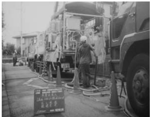
写真4 不明管の改修補修工事
