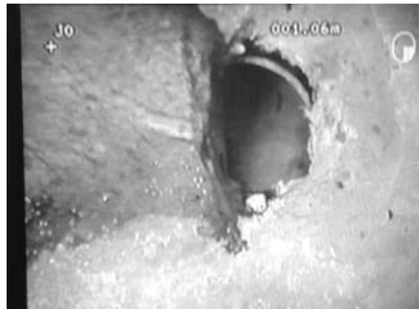
写真3 不明管からの雨水管への汚水の流入の確認テスト（着色水によるテスト）
