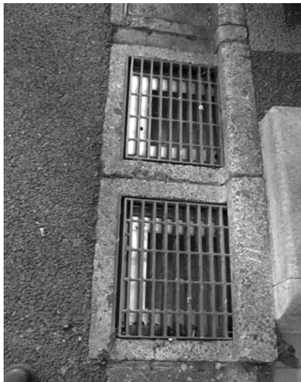
写真5 雨水マスのふたをして設置終了
