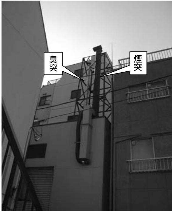
写真1 煙突と臭突の状況
