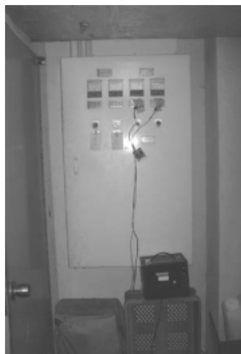
写真 2 稼働状況記録計の取付状況
