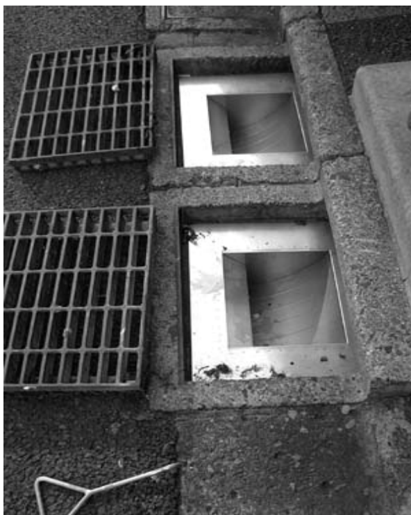
写真4 防臭リッドを設置（写真は2連のます）
