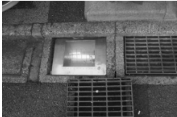
写真3 防臭リッドを雨水マスに設置した状態
