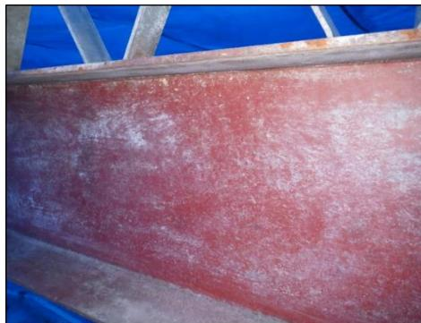
図4.15.4 除去面に再付着
