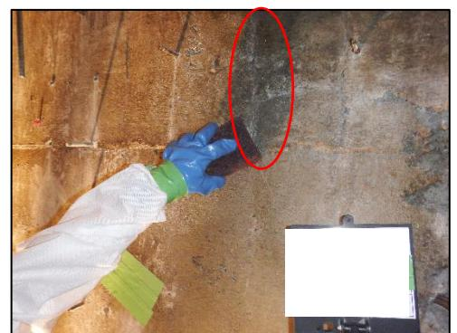
図4.15.9 コンクリート壁面に残った石綿の
