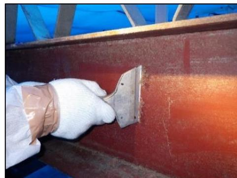
図4.15.5 再付着した石綿の除去
