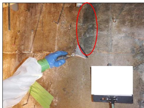
図4.15.8 コンクリート壁面に残った石綿の
