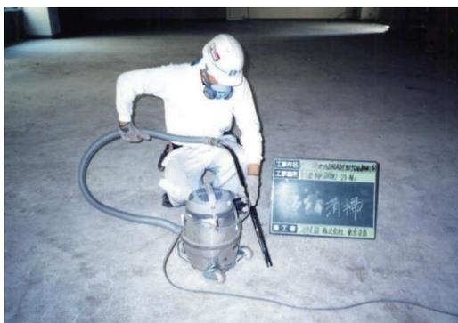
図4.11.21 清掃 高性能真空掃除機使用例
