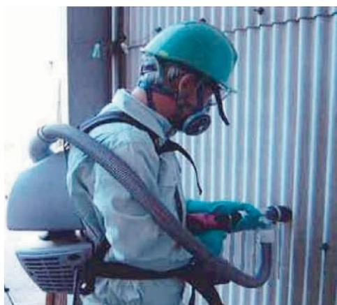
図4.11.7 機械工具による切断例
