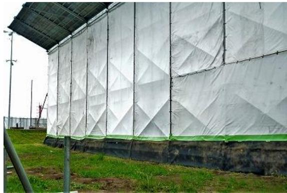
周囲への飛沫飛散防止養生例（外部）
