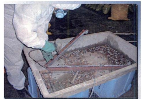
図4.11.17 掻き落とし除去作業の例
