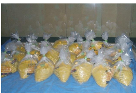
図 4.7.78 除去した石綿廃棄物の保管
