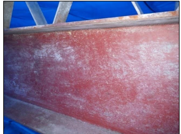
図 4.7.70 再付着した石綿の例
