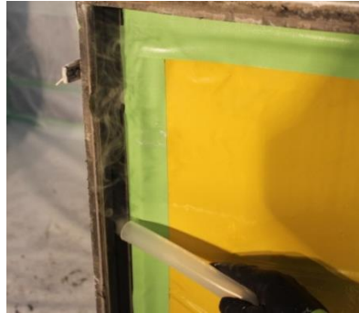
図 4.7.49 HEPA フィルタ 周辺部分
