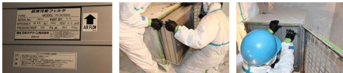
図 4.7.86 フィルタの取り付け
