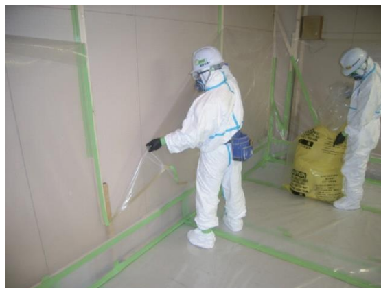
図 4.7.91 隔離シートの撤去
