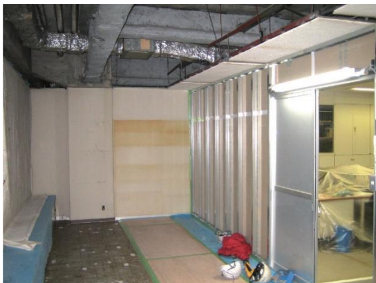
図 4.7.2 テナントビルの施工区画 (内部側)
