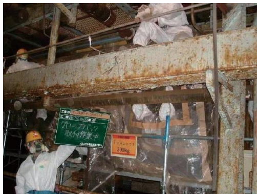
図 4.10.8 グローブバッグ取付作業中
