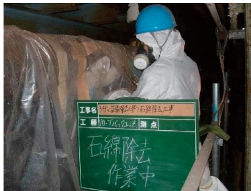
図 4.10.9 石綿除去作業中 1
