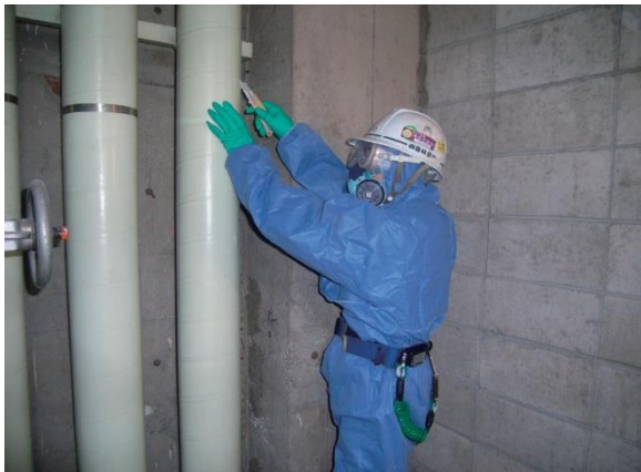
図 4.8.2 保温材被覆撤去
