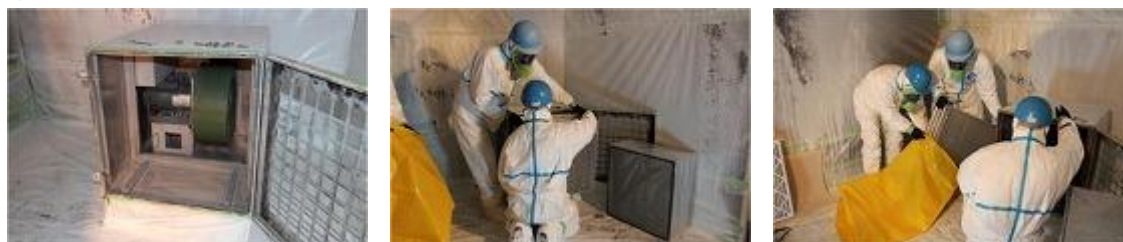
図 4.7.85 HEPAフィルタの交換
