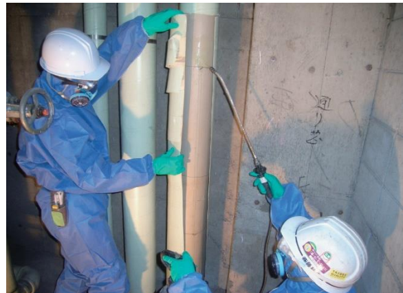
図 4.8.3 保温材の湿潤化→取り外し
