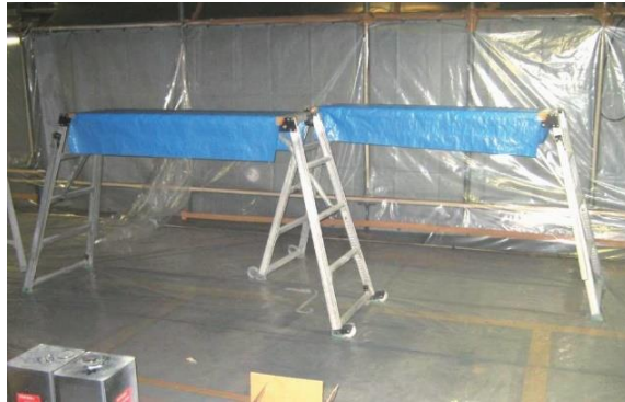
図 4.7.57 可搬式作業台の例
