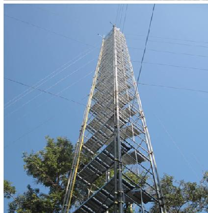
写真2 粒子状物質の観測用鉄塔
