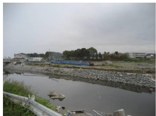
津波被害状況
