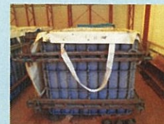
型枠のセット状況
