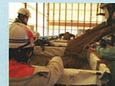
セメント固型化剤の注入
